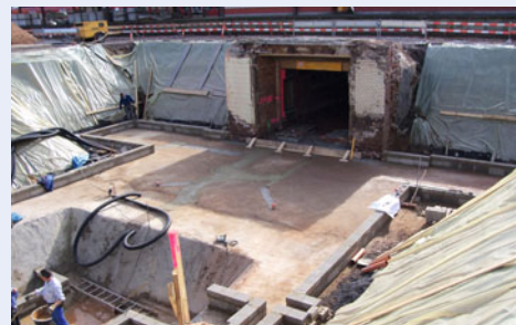
Umbau des Eurobahnhofs in Saarbrücken
