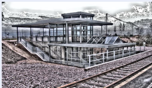
Neubau des Zugangs zum Hauptbahnhof Wittlich
