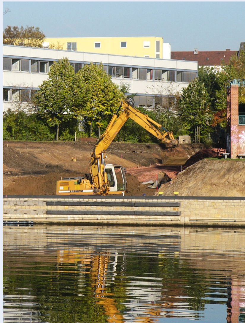
Neubau der RoRo-Anlage in Saarbrücken an der Saar
