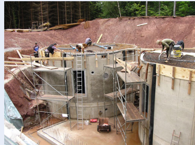
Neubau des Hochbehälters in Dautweiler
