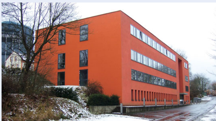
Neubau des Dienstgebäudes des Landkreises Neunkirchen
