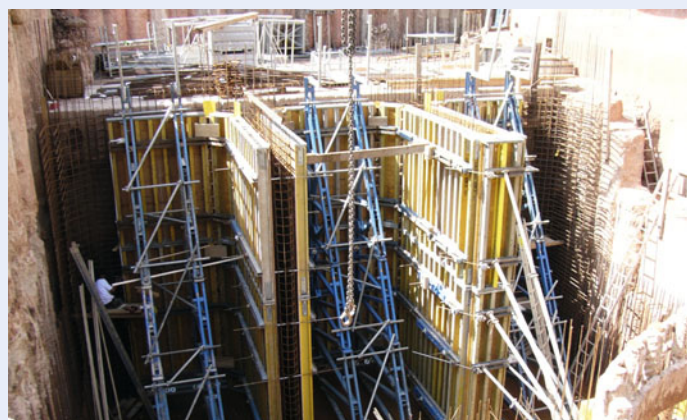
Neubau des Pumpwerks am Seffersbach in Merzig
