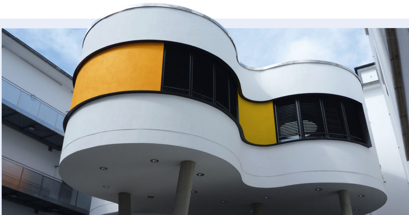
Um- und Anbau des Centre Hospital Emile Mayrisch in Dudelange
