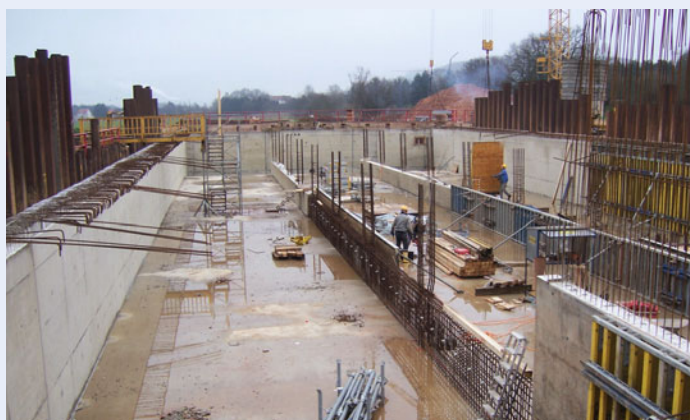
Neubau des Regenüberlaufbeckens (RÜB) in Losheim
