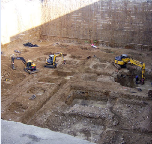
Erdarbeiten Bâtiment F8 in Findel in Luxembourg
