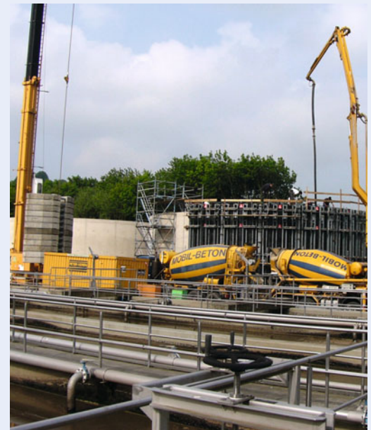
Umbau der Kläranlage Saarburg
