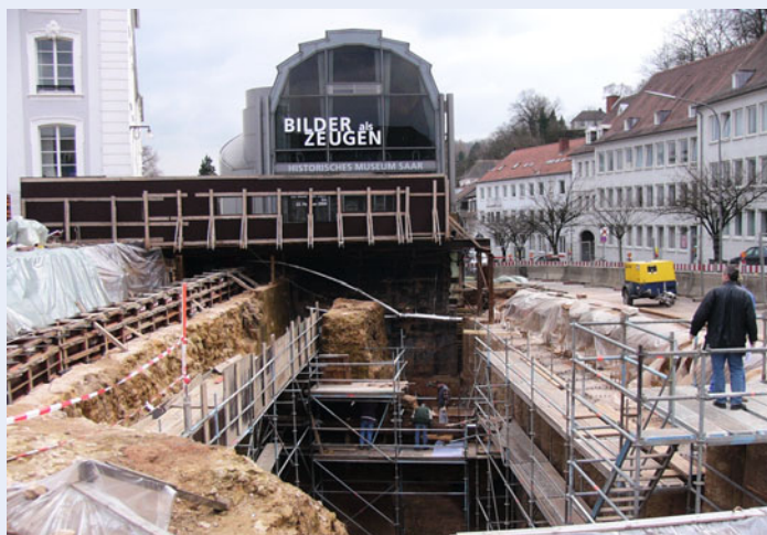
Freilegung der Kasematten am Saarbrücker Schloss
