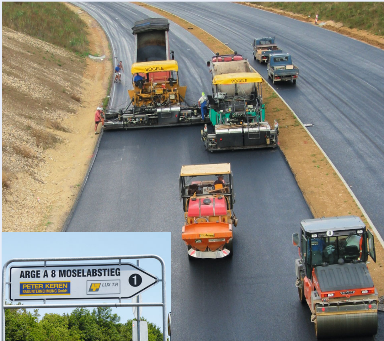
Neubau der Autobahn A8 Moselabstieg bei Perl
