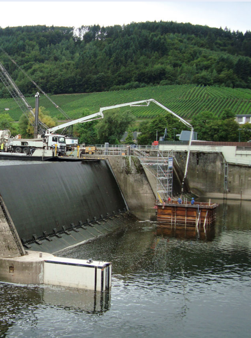
Verlängerung von Wehrpfeilern in Trier und Detzem
