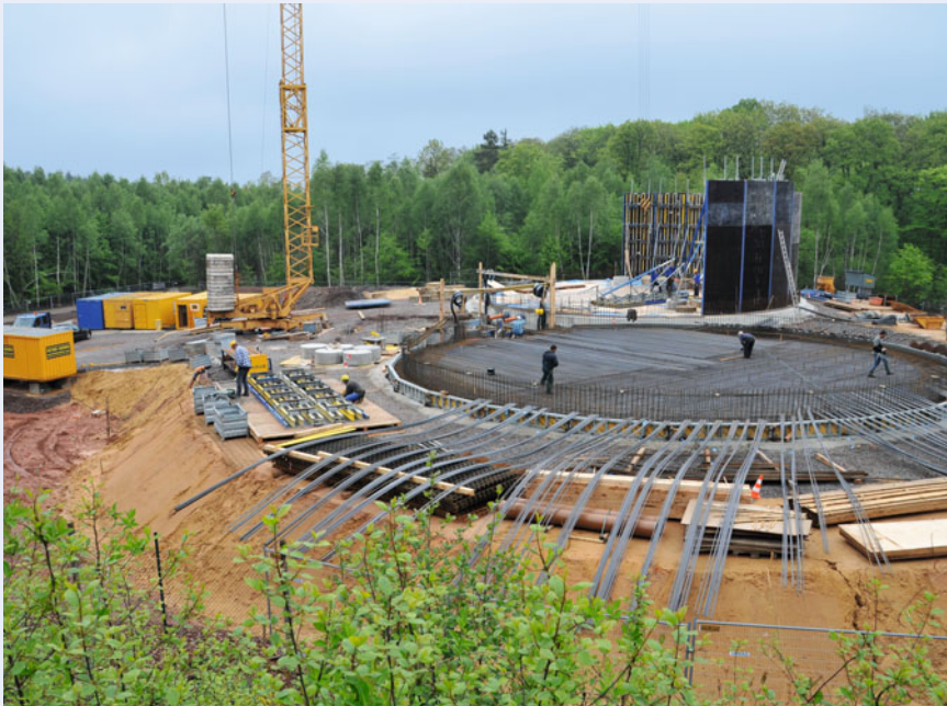
Neubau des Hochbehälters Lachwald in Saarwellingen
