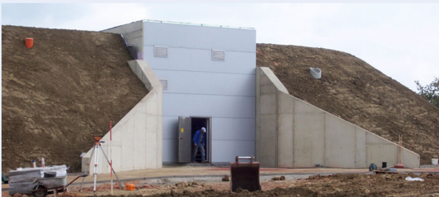
Neubau des Hochbehälters in Nennig
