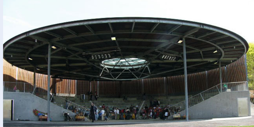
Neubau des LOTTO-Forums in Trier im Zuge der Landesgartenschau
