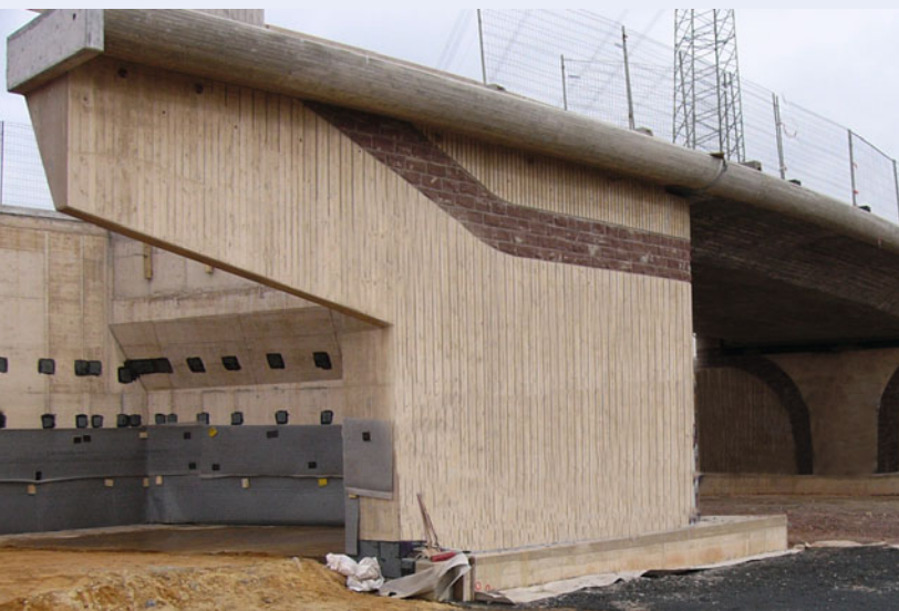
Neubau der Brücke BW 2023 im Zuge der Bundesstraße B269 Orts- Umgehung Ensdorf
