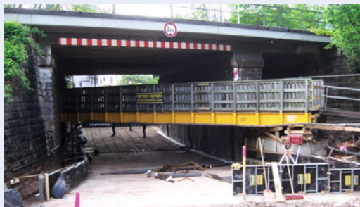
Tieferlegung der Eisenbahnunterführung „Am Stahlhammer“ in Saarbrücken-Schafbrücke
