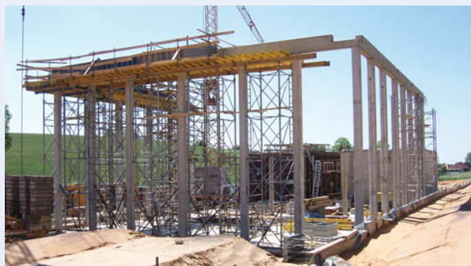
Neubau der Trinkwasseraufbereitungsanlage in Elm
