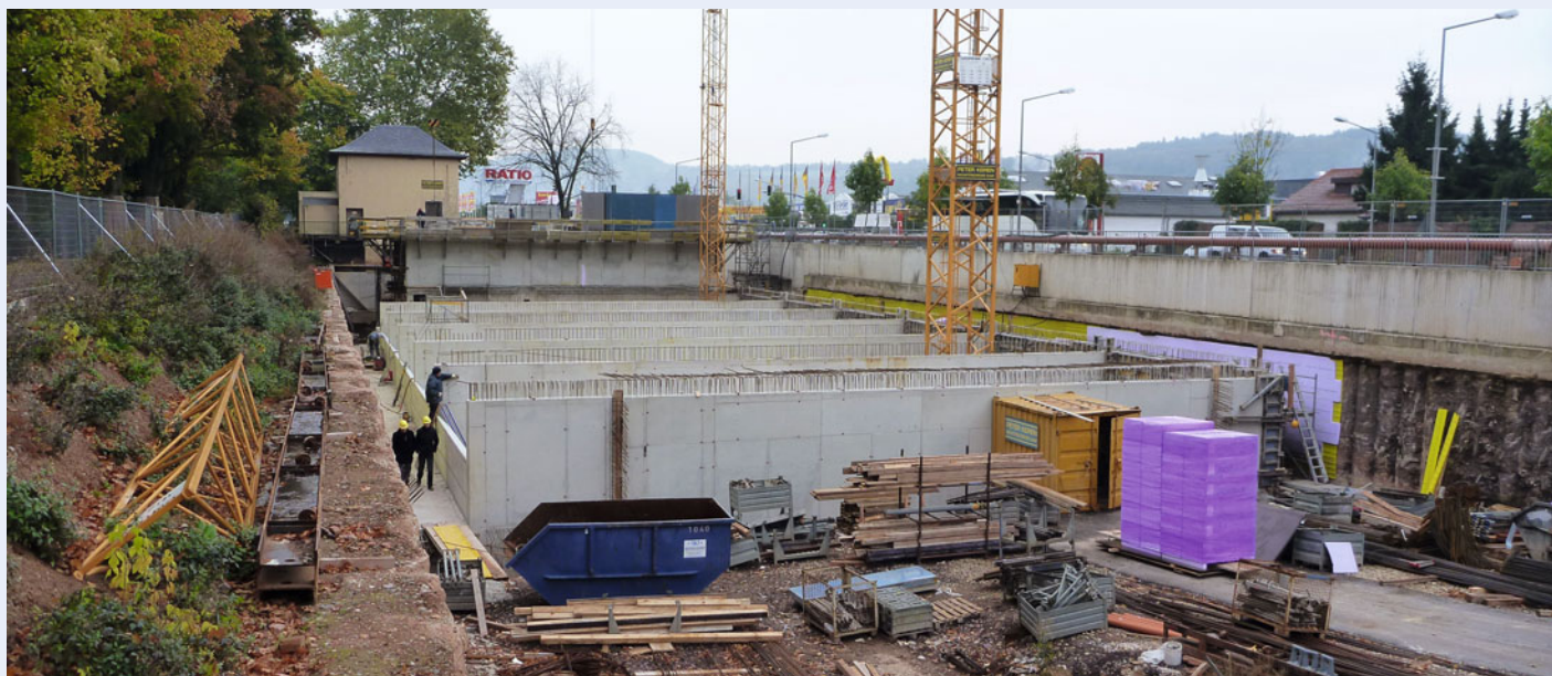
Neubau des Regenüberlaufbeckens (RÜB) 13 mit Pumpwerk in Trier
