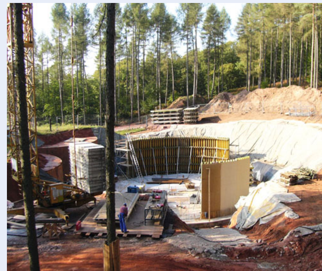
Neubau des Hochbehälters in Saarhölzbach
