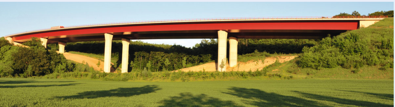
Neubau der Hungerbachbrücke (BW 1585) im Zuge des Neubaus der Autobahn A8 Moselabstieg in Perl
