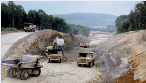
Erdarbeiten im Zuge des Neubaus der Autobahn A8 Moselabstieg in Perl
