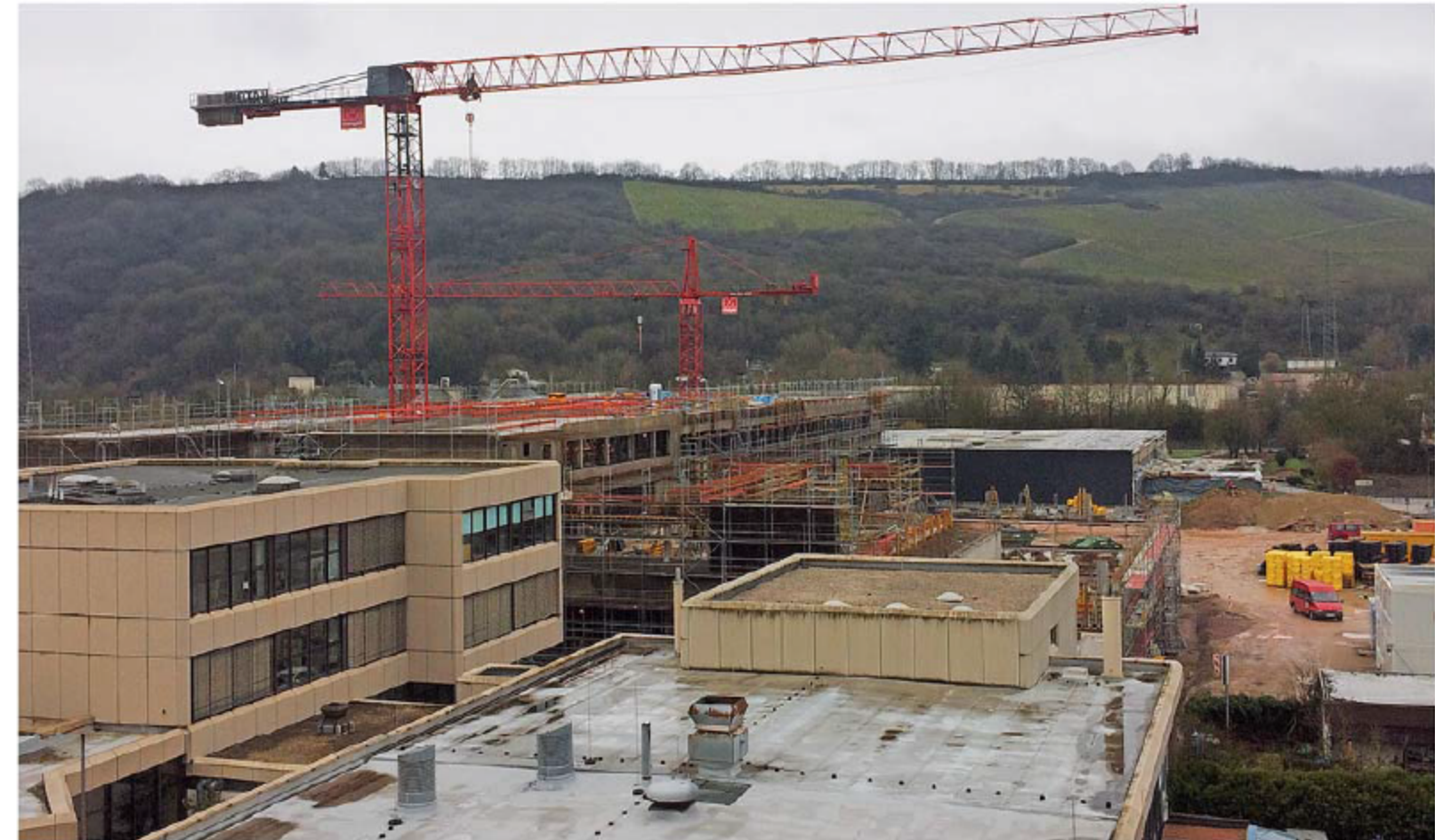
Der Neubau des Bildungszentrum der Handwerkskammer Trier nimmt allmählich Kontur an. Mitte 2019 sollen die ersten Lehrlinge und Meisterschüler die neuen Werkstätten nutzen können.
